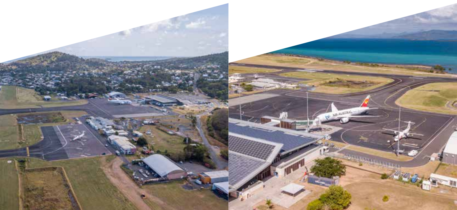
Vues générales du site : vers le nord de l'aéroport (urbanisation de Pamandzi et de Dzaoudzi-Labattoir à l'arrière-plan) et vers l'ouest (secteur artificialisé de l'aéroport et littoral le long de la piste actuelle).
