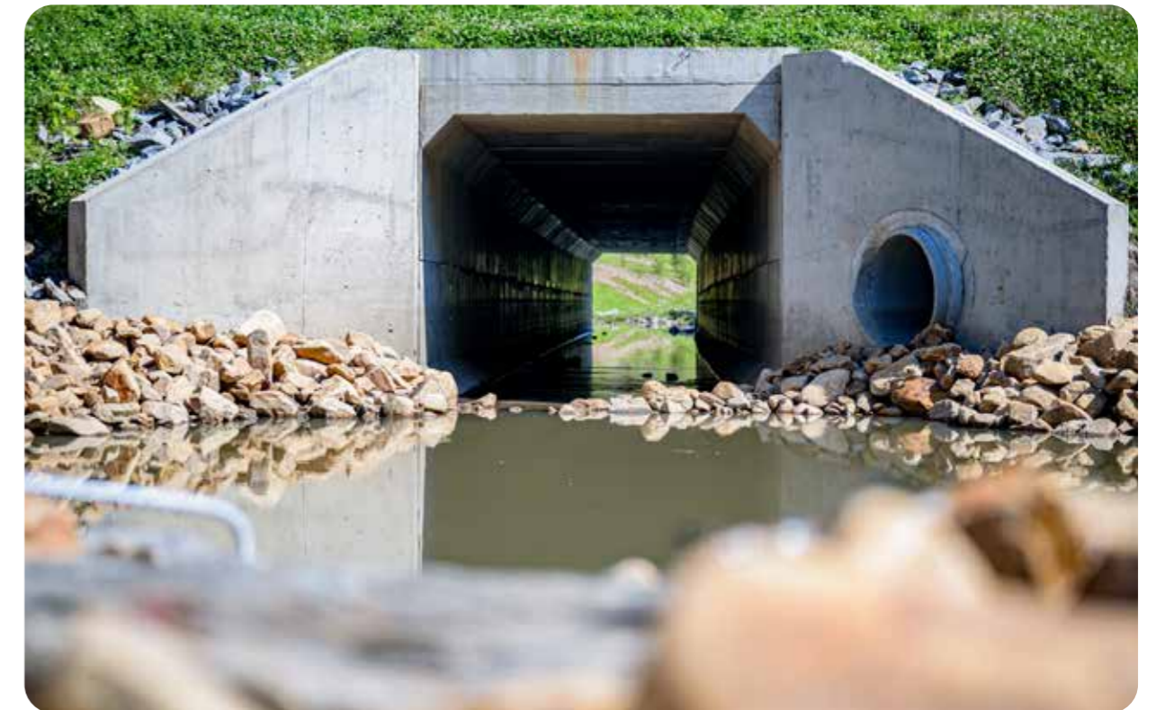
Exemple d'ouvrage de rétablissement d'un cours d'eau.
