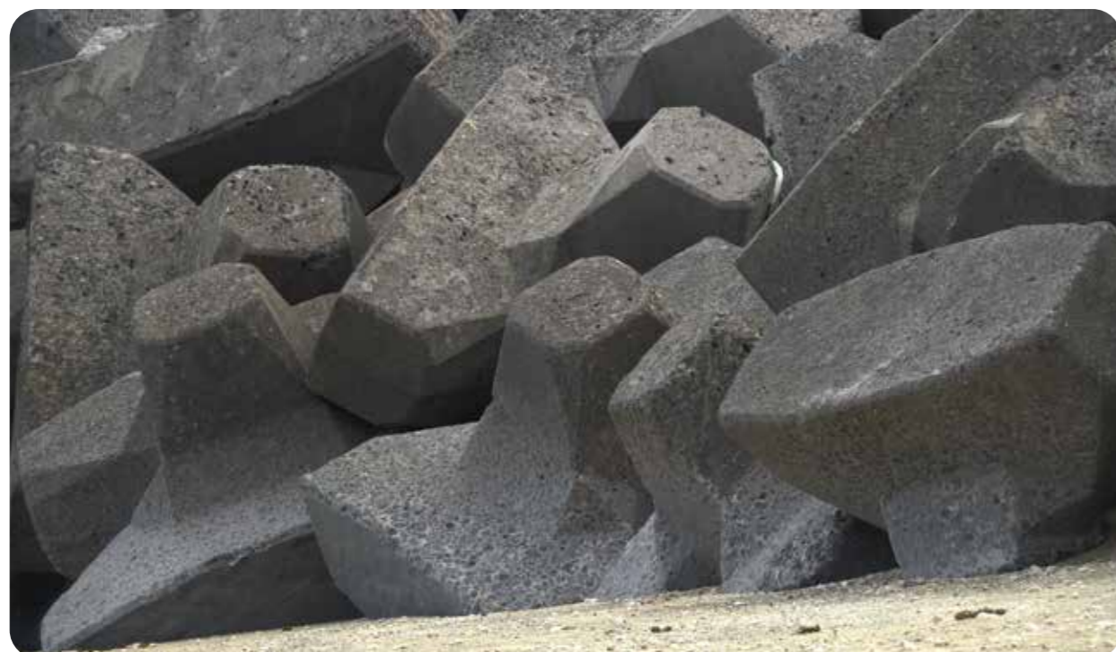
Ouvrages de protection maritime de type accropodes
