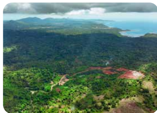
Vue générale du site de Bouyouni / M'Tsangamouji.
