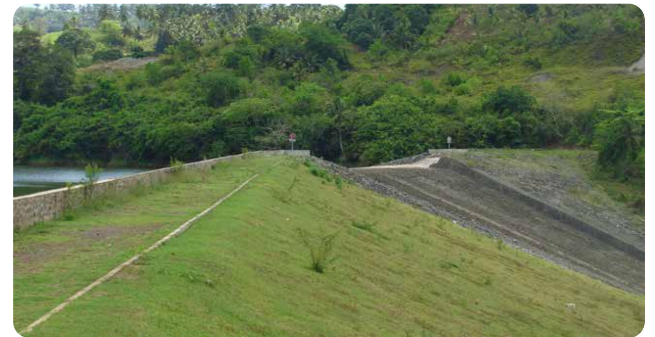
Barrage de la retenue collinaire de Dzoumogné - Plg56 / Creative Commons
