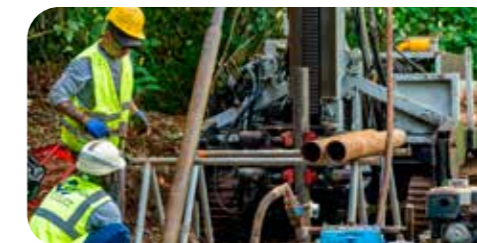
Sondage géotechnique sur le site de Bouyouni/M'Tsangamouji
