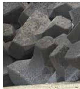
Protection du remblai-digue avec une carapace d'engrèvements (ouvrages en béton qui seront réalisés sur place).
